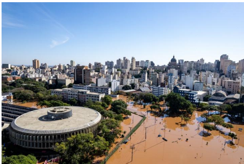
Figura 2 - Vista área da Procergs no momento da inundação. Foto: Gustavo Mansur/ Palácio Piratini.
