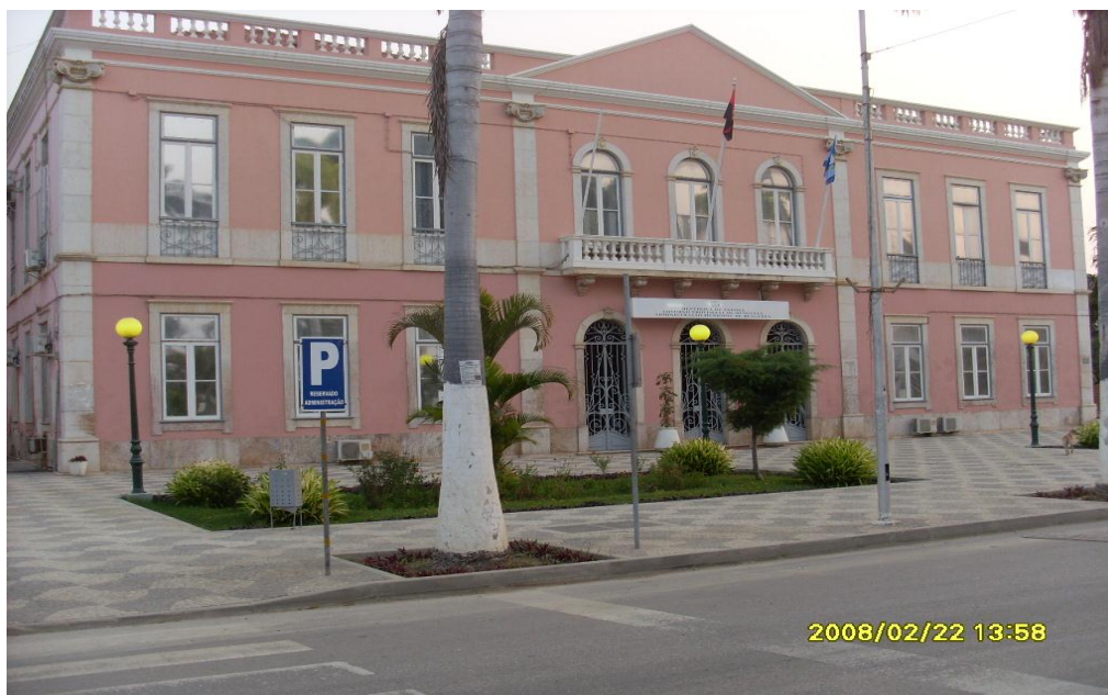
Figura:1 Edifício da Administração Municipal de Benguela
