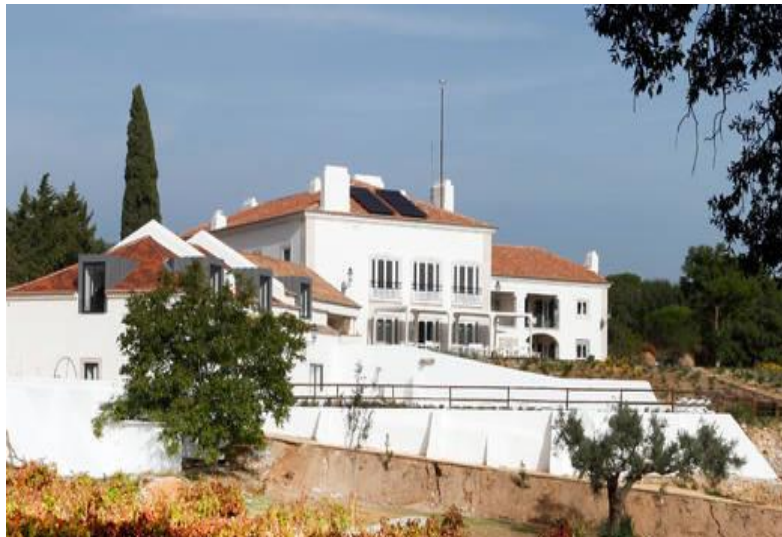
Figura 9 – Painéis solares termodinâmicos.
