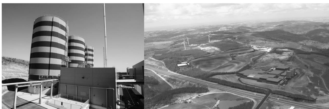
Figura 3 – Central de Tratamento de Resíduos Sólidos Urbanos da Tratolixo, S.A.
