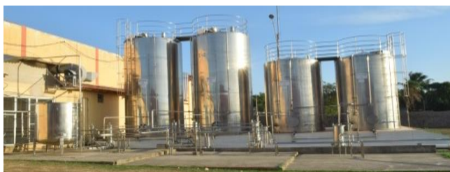
Figura 3: Tanques para água mineral em aço inox.
