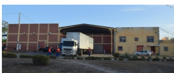
Figura 18: Vista do Galpão 2.
